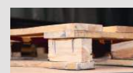
Widoczne ostrza gwoździ lub ponad 2 trzpienie gwoździ na paletę
